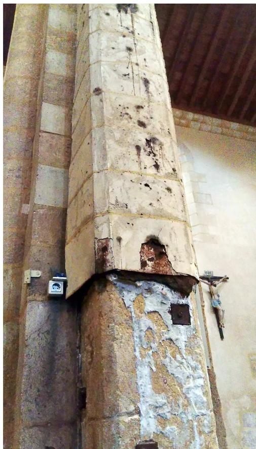
observar que «algo no iba bien» debido a la aparición de manchas de óxido en dicho revestimiento metálico. Estas manchas estaban originadas por la humedad del subsuelo, absorbida por capilaridad y comenzaban a ser preocupantes.
