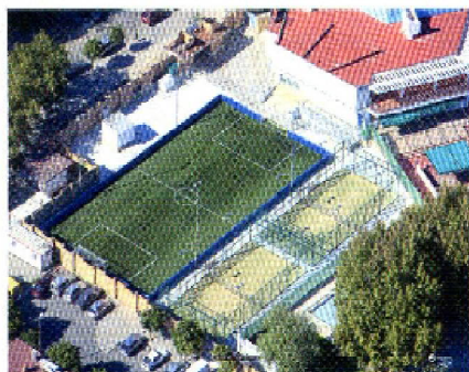
REMEDIACIÓN Y MEJORA DE INSTALACIONES DEPORTIVAS EN CÓRDOBA
